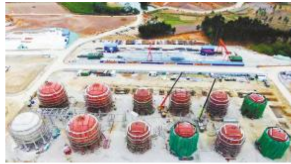
云南通威高纯晶硅项目12台球罐组对安装工作圆满完成
