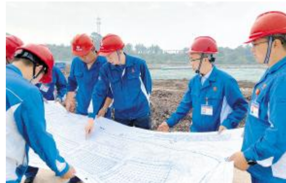
永祥光伏科技指挥长袁中华深入永祥光伏科技项目建设现场指导工作
