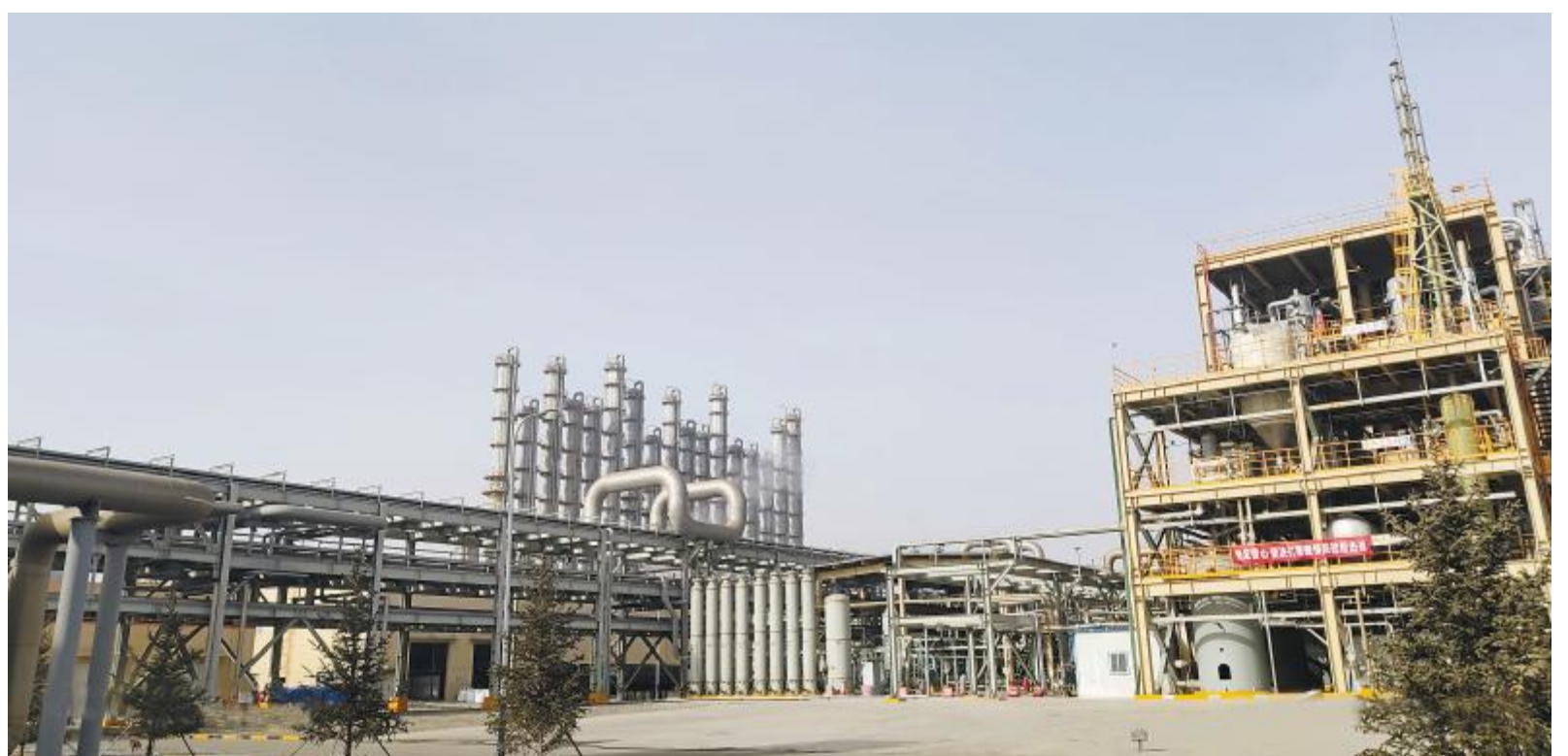
内蒙古通威高纯晶硅厂区
