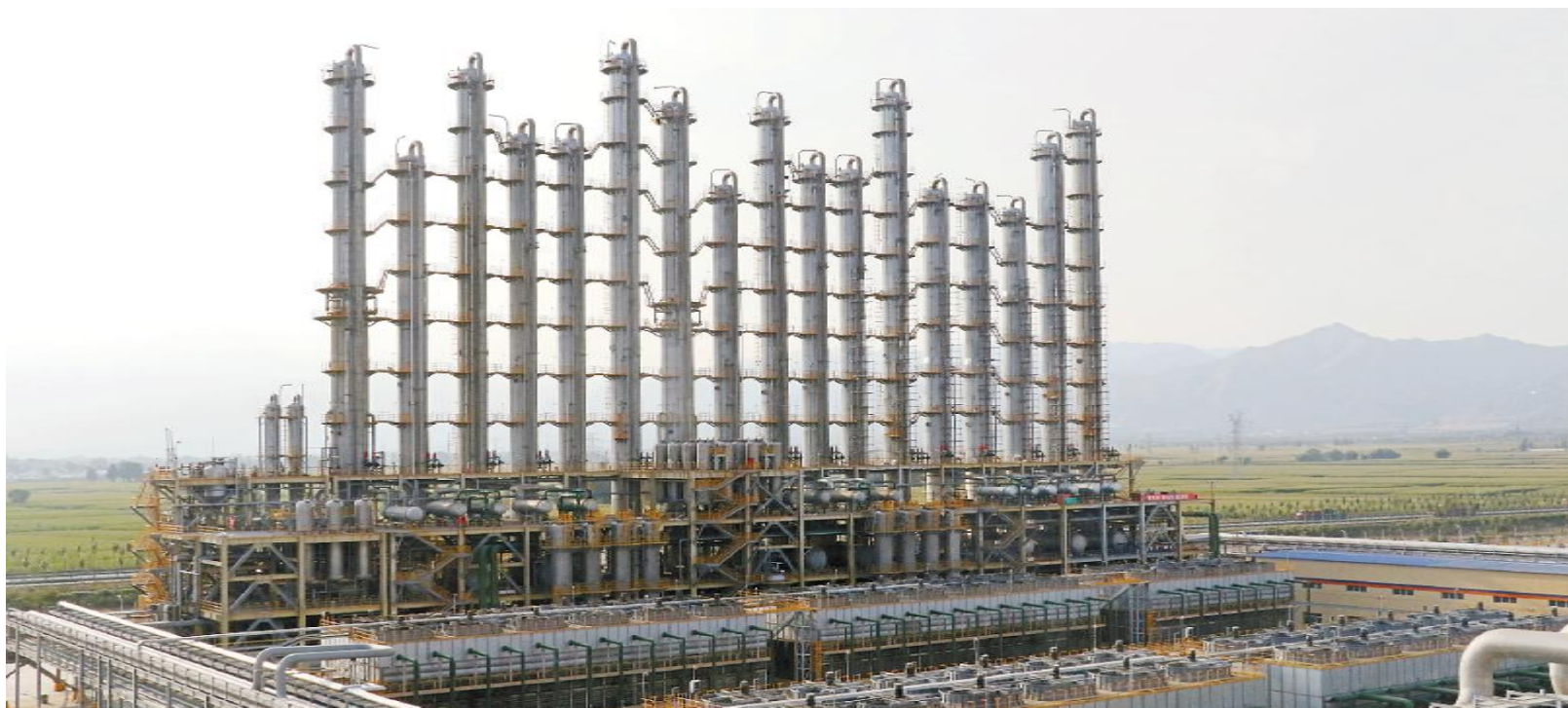
内蒙古通威高纯晶硅精馏塔装置
