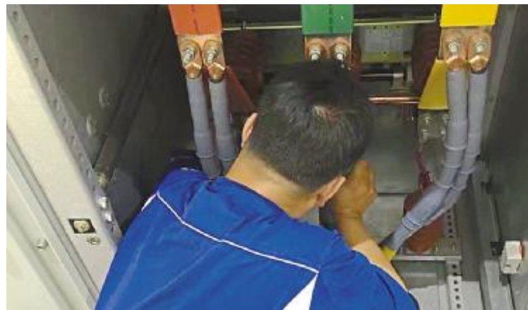
维修高压开关柜,作业面窄,汗水浸湿衣服
