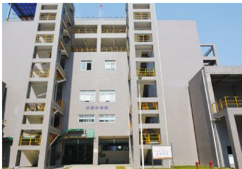
淡盐水浓缩装置楼
