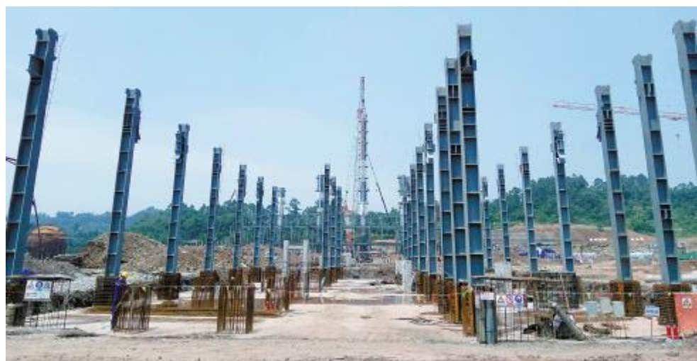
尾气回收钢构安装中
