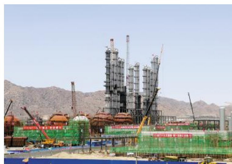
永祥股份包头高纯晶硅项目建设现场
