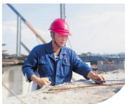
袁志林在项目现场查验空分制氮设备基础
