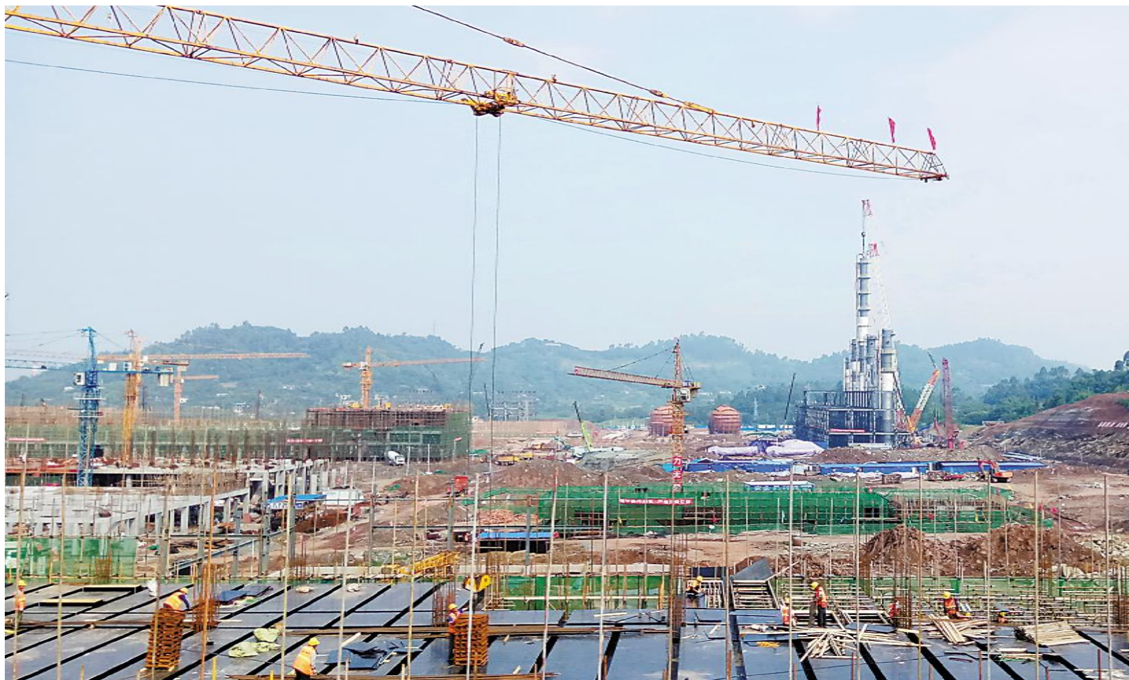
永祥新能源正快速推进项目建设
