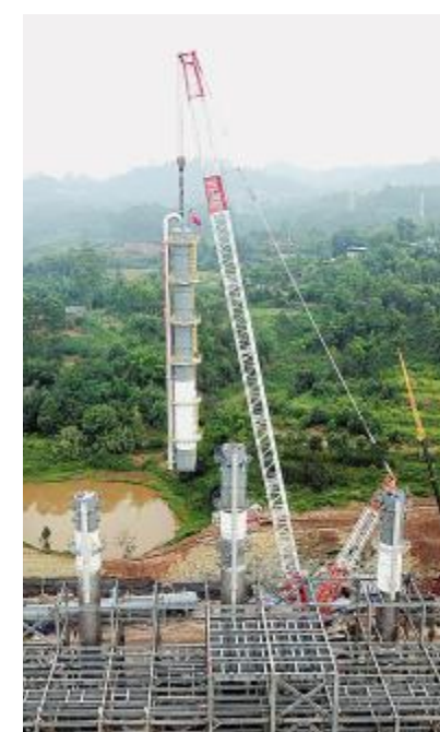
上段精馏塔吊装中
