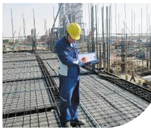
魏科在项目建设现场验收照明插座预埋管
