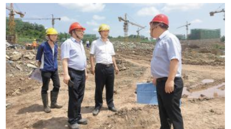
永祥新能源项目建设现场管理交流
